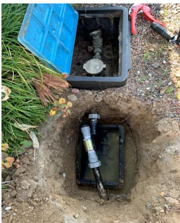
NO.3 本管切断 接続
